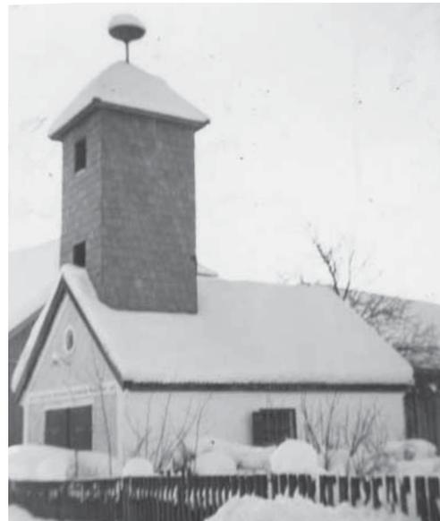
**Das alte Zeughaus in originalem Zustand.** Der mit Schindeln verkleidete Schlauchturm wurde 1954 mit einer Sirene ausgestattet, er wurde in den Siebziger-Jahren abgenommen.
