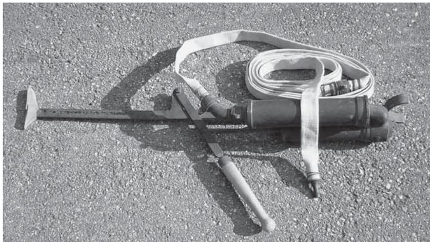
**Krückenspritze.** Diese einfache Handpumpe war der Vorläufer des Feuerlöschers, gemacht für die rasche Bekämpfung von Kleinbränden. Die von Walchen entfernter gelegenen Dörfer wurden in den Dreißiger-Jahren damit ausgestattet.
